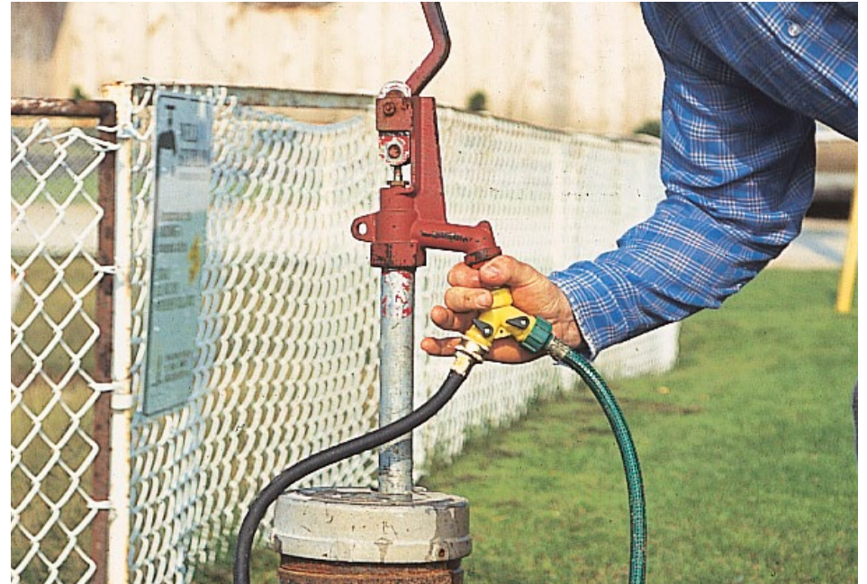
Ce tubage métallique d'un puits foré à la sondeuse est équipé d'un robinet de type borne-fontaine à l'épreuve du gel et d'un antirefouleur.
