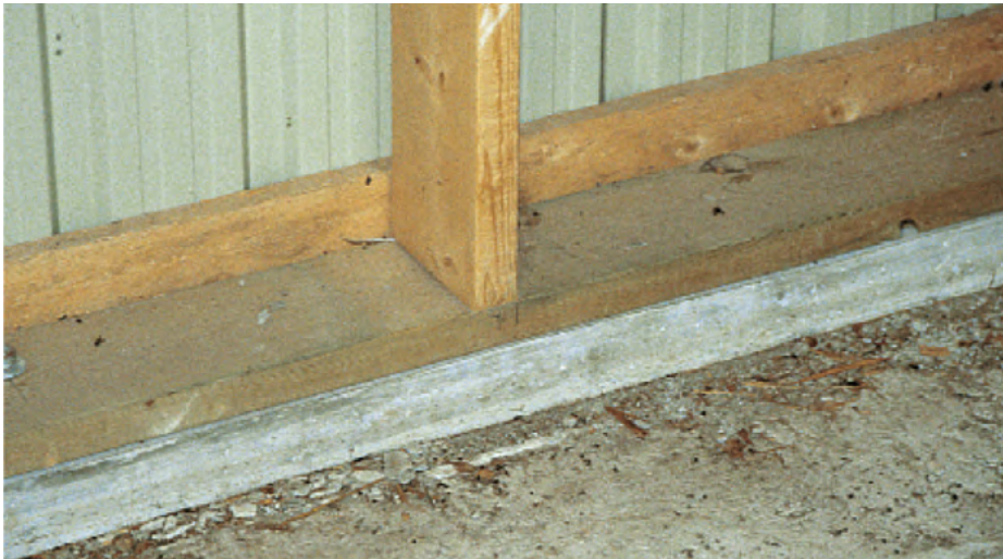
Un plancher imperméable entouré de barrières de retenue permettra de contenir les produits déversés et d'en faciliter le nettoyage.
