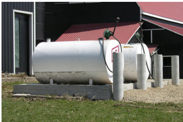
Une base solide aide à garder la zone du réservoir de stockage de combustible exempte de végétation.
