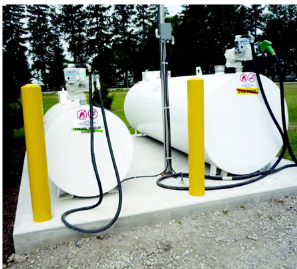
Des bornes installées le long des voies de circulation permettent de protéger les réservoirs de stockage de combustible contre l'impact de véhicules.
