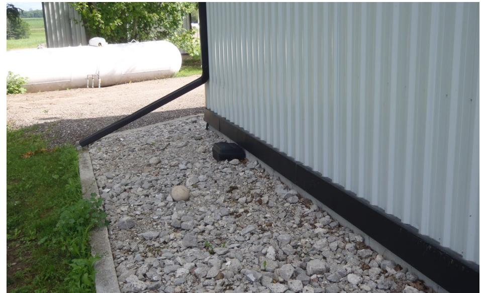
**Les gouttières et les drains de fondation et de semelle ne doivent pas être raccordés au système d'égout.**
