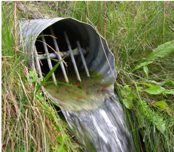
Les drains souterrains sont des conduits vers les eaux de surface, et les sites de compostage doivent être situés à au moins 10 m (33 pieds) de distance.
