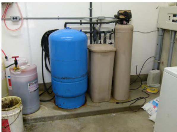
Les adoucisseurs d'eau et autres types de systèmes de traitement de l'eau doivent être inspectés et entretenus chaque année.
