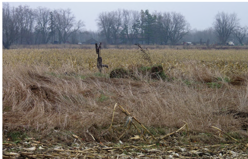
Les puits qui n'ont pas été correctement mis hors service constituent une voie d'accès directe aux eaux souterraines.
