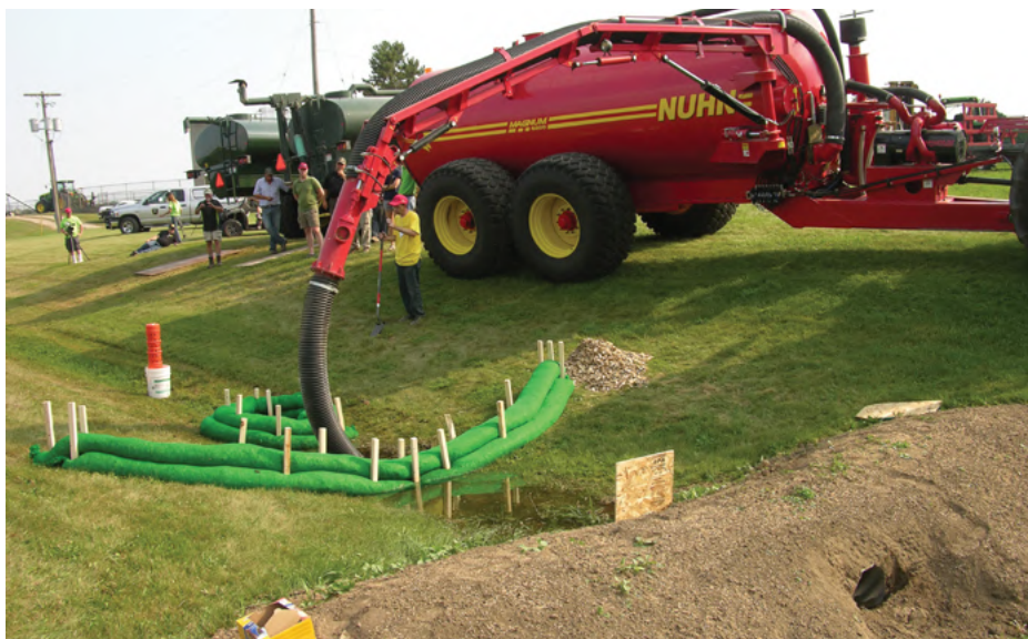
Contenir le déversement à l'aide d'une grue, de bermes en terre, de balles de paille ou de sacs de sable
