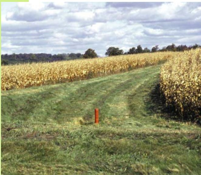
Les voies d'eau gazonnées sont des rigoles enherbées en forme de cuvette et en pente qui se jettent dans le réseau de drainage souterrain. Elles ont pour but de détourner les eaux de ruissellement et de les évacuer vers un exutoire convenablement protégé.
