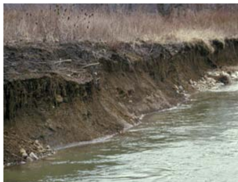
Érosion des berges causée par l'écoulement de l'eau.
