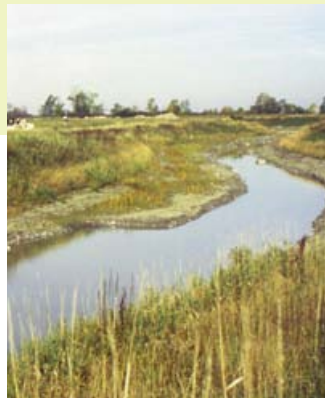
Des rapides et des bassins ont été disposés de manière stratégique dans le canal de drainage municipal de la branche sud de la rivière Nation Sud dans le comté de Dundas. Ces travaux faisaient suite à un rapport d'ingénieur et visaient à procurer un habitat aux poissons.
