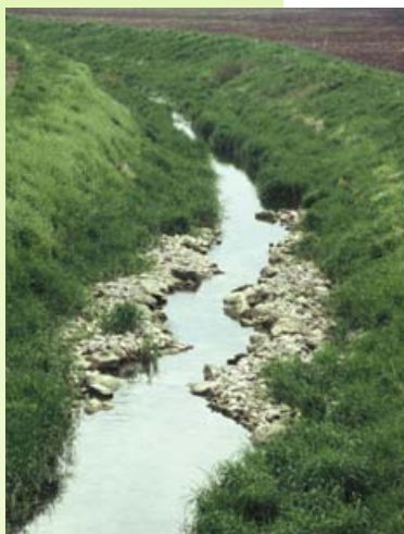
La création de RAPIDES et de FOSSES contribue à ralentir le courant. Des matériaux grossiers sont placés dans les lits des cours d'eau pour créer des rapides et les lits sont creusés pour créer des fosses.
