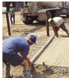
Étape 3 : mettez la touche finale au béton coulé à l'aide d'une taloche.
