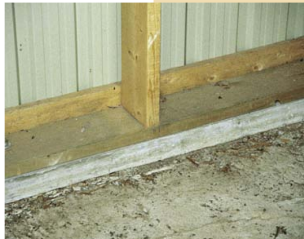
L'assise doit être fixée au rebord du plancher de béton coulé à l'aide de boulons d'ancrage.
