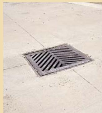
Un puisard est une fosse ou un réservoir servant à recueillir les liquides. Il est conçu pour la récupération et le transfert des déchets à court terme, **PAS** pour l'entreposage.
