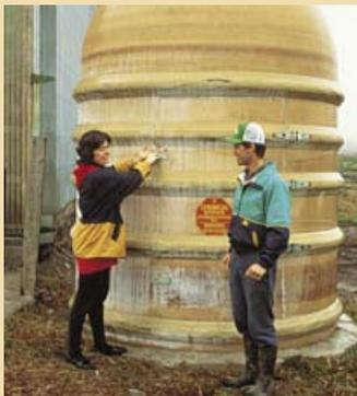
L'extrémité d'un réservoir à essence usagé en fibres de verre a été fixée à un plancher en béton sans joints (doté d'un rebord de 150 mm [6 po.]), créant ainsi un entrepôt unique pour les pesticides. Le coût total du matériel était de 185 \$.
