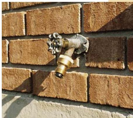
**Ce clapet anti-retour fixé au robinet évitera le siphonnement dans la source d'eau.**
