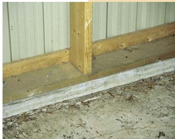
L'assise doit être fixée au rebord du plancher de béton coulé à l'aide de boulons d'ancrage.
