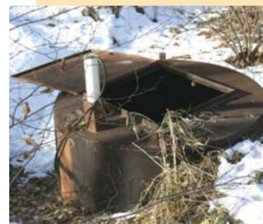
Ce conteneur a servi lors d'un récent essai d'élimination des cadavres de moutons sur site.
