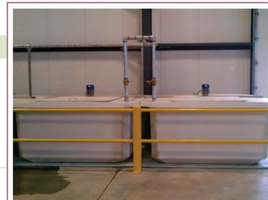
Placez les réservoirs dans un endroit isolé ou peu fréquenté, et à l'abri des chocs accidentels.
