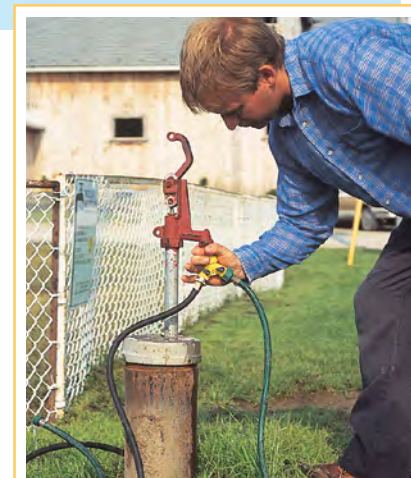
Ce tubage métallique d'un puits foré à la sondeuse est équipé d'un robinet de type borne-fontaine à l'épreuve du gel et d'un antirefouleur.
