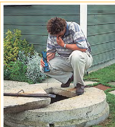
L'inspection du bouchon doit faire partie du programme d'inspection annuelle du puits.
