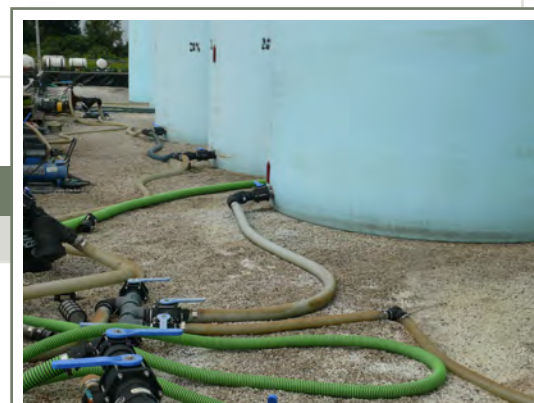
Le recours à un système fermé pour le transfert des liquides réduit les risques de déversement.
