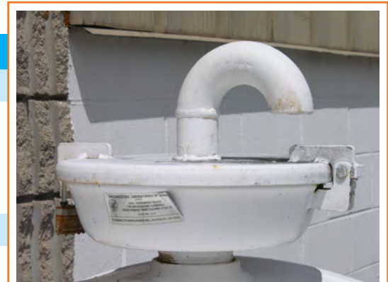
Le dispositif de protection contre les débordements est conçu de manière à empêcher de remplir le réservoir à plus de 95 % de sa capacité.
