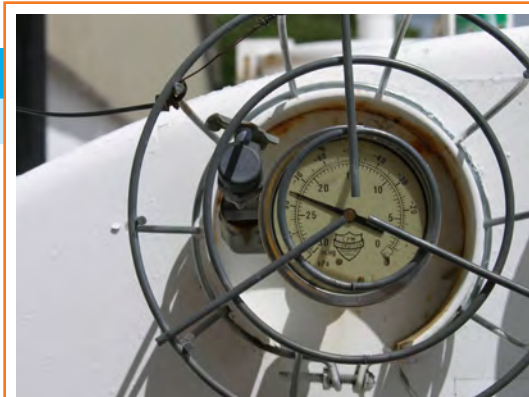
Une lecture du vide au vacuomètre indique que les deux parois d'un réservoir à double paroi sont étanches.
