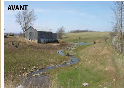
AVANT En raison d'une trop faible distance de séparation et d'un relief en pentes, cet ancien enclos risquait de contaminer l'eau de surface.
