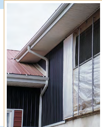
Grâce à un réseau de gouttières bien conçu, l'eau propre est acheminée loin de l'aire d'entreposage et de la cour à bestiaux.
