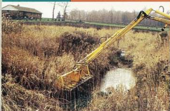
La végétation surabondante de ce canal peut être enlevée afin d'améliorer le débit de l'eau. Dans certains cas, cette mesure augmente même la valeur de l'habitat.
