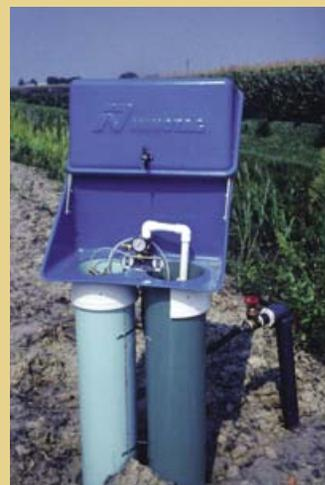
**Dispositif vendu sur le marché pour contrôler l'apport d'eau dans un système d'irrigation souterraine par le réseau de drainage.**
