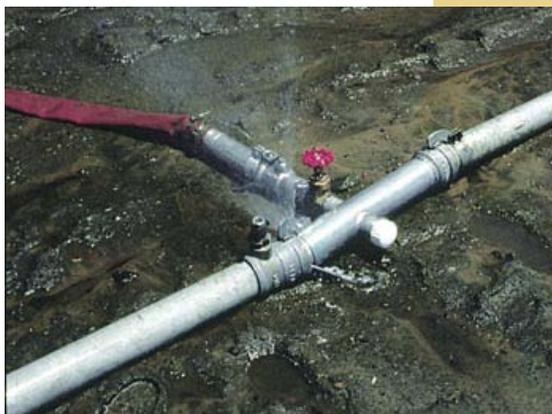
**Les raccords qui coulent gaspillent l'eau. Examiner les raccords avec soin et effectuer les réparations nécessaires.**
