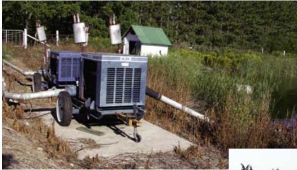
Une pompe alimentée au diesel, sur une plateforme de béton, puise l'eau d'un réservoir.
