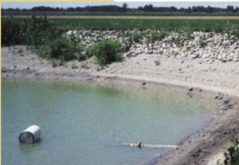
On stocke dans ce grand réservoir l'eau d'irrigation pour la saison de croissance. Cette eau, qui a été puisée dans les fossés de drainage en hiver et au printemps, sera graduellement utilisée pendant les mois d'été.
