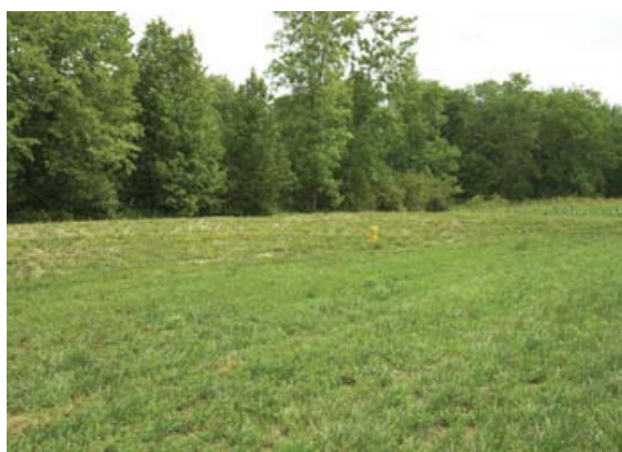
Voici un bel exemple d'un bassin de captage et de sédimentation qui a été bien construit. Il est tapissé d'une culture fourragère établie.
