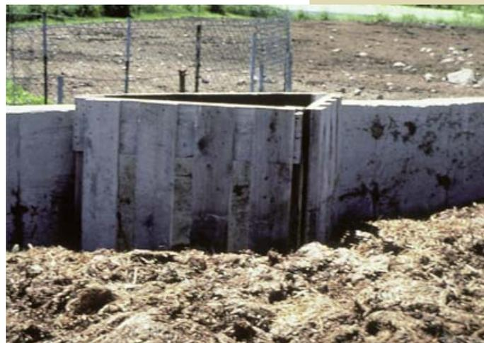
Les systèmes d'entreposage de fumier solide comprenant une structure pour la collecte des eaux de ruissellement peuvent accepter d'importants volumes de litière et de liquides.
