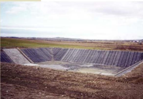
Les revêtements synthétiques doivent être ancrés ou liés à l'installation. Tout dommage ou toute perforation constaté doit être réparé conformément aux instructions de l'ingénieur.
