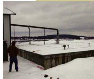
Les structures d'entreposage du fumier liquide couvertes dégagent moins d'odeurs.
