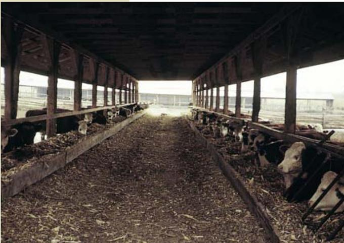
La présence d'un toit au-dessus d'un enclos à bétail ou d'une structure d'entreposage de fumier solide empêche la pluie et la neige d'y pénétrer. La pluie et la neige fondue augmentent le volume des eaux de ruissellement qui doivent être entreposées ou traitées. L'eau qui s'ajoute peut aussi modifier la teneur du fumier en matière sèche et obliger à utiliser un autre type de système de traitement.
