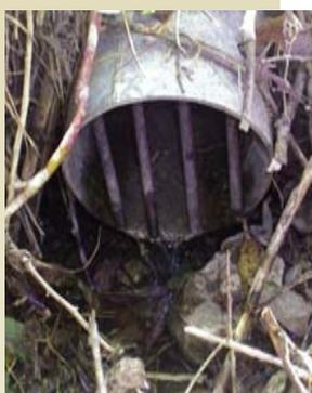
**Il faut surveiller les sorties de drainage afin de pouvoir se rendre compte rapidement de la présence d'effluents contaminés.**
