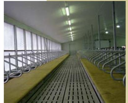
Les caniveaux à écoulement continu donnent les meilleurs résultats lorsqu'on utilise un minimum de litière.
