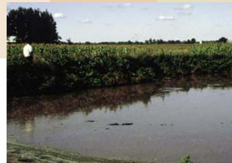
Structures en terre battue — pourvu que l'emplacement, les caractéristiques du site et la conception de la structure s'y prêtent, ces structures peuvent convenir à l'entreposage du fumier liquide, des eaux de ruissellement et des eaux de lavage.
