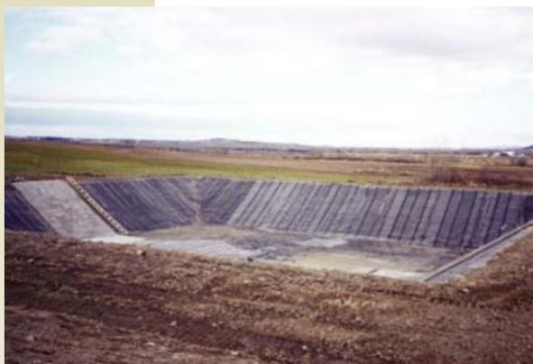
Les revêtements synthétiques doivent être ancrés ou liés à l'installation. Tout dommage ou toute perforation constaté doit être réparé conformément aux instructions de l'ingénieur.
