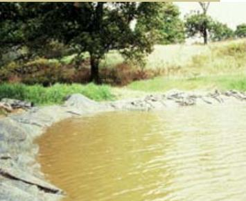
Les sols de texture grossière peuvent nécessiter le dépôt d'une couche de béton, la pose d'un revêtement synthétique ou le compactage d'une couche d'argile provenant d'ailleurs pour empêcher toute eau contaminée d'atteindre l'eau souterraine.
