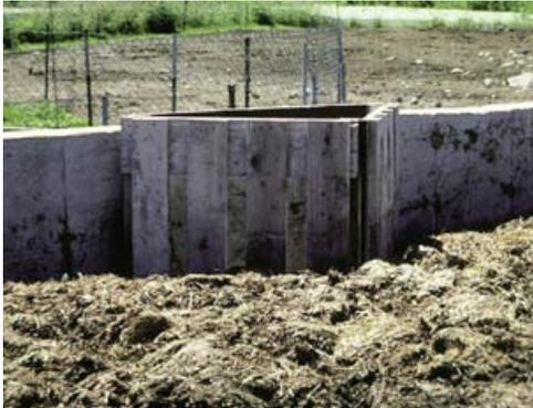
Une structure d'entreposage de fumier solide doublée d'un système de collecte des eaux de ruissellement permet de capter tous les liquides, mais oblige à utiliser deux modes d'épandage.
