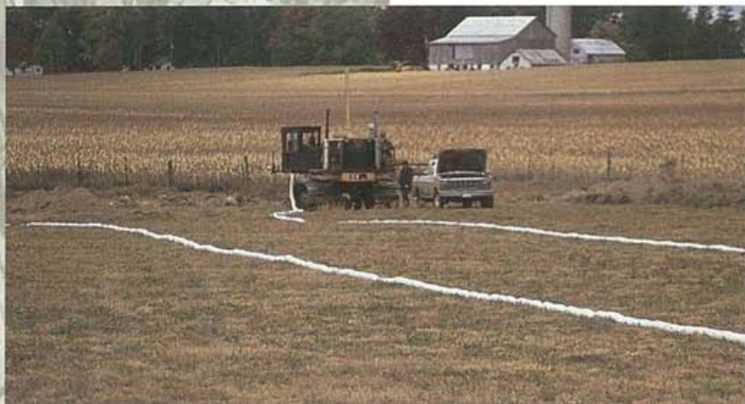
L'installation de drains agricoles est un aspect important de la gestion des sols.
