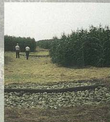
Une structure de contrôle alliant roche et rondins réduit la pente et permet de maîtriser l'eau de ruissellement.
