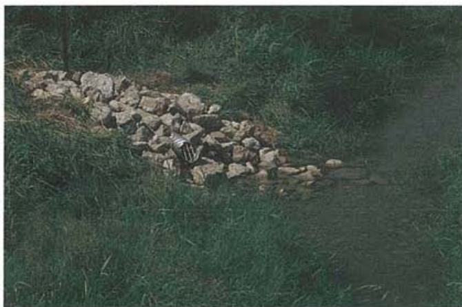
Sortie de drainage adéquatement installée.
