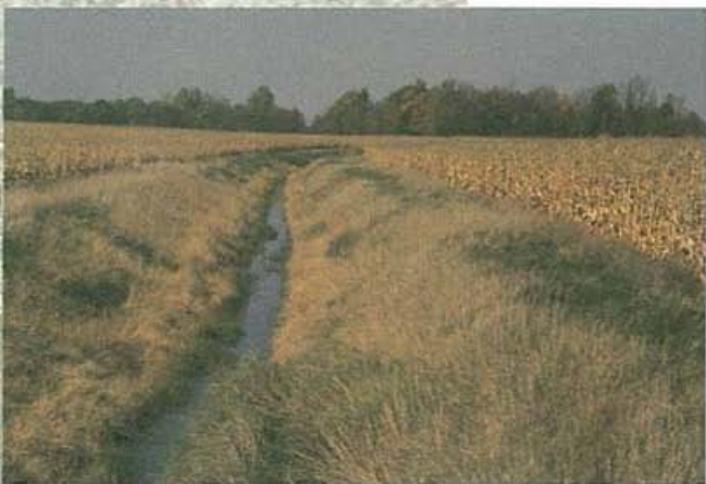
Fossé municipal bien aménagé.
