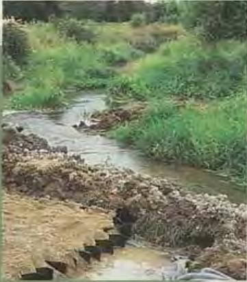
Une terrasse avec fossé intercepteur limite le débit d'eau d'un côté de ce cours d'eau pendant l'installation d'une traverse de machinerie.
