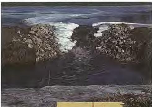
► Un drain intercepteur empêche l'écoulement de l'eau le long des berges, consolidant ainsi les talus.
