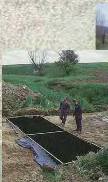
Lorsqu'il est rempli de gravier, le système de confinement par grilles plastiques procure une traverse de machinerie relativement peu coûteuse.
