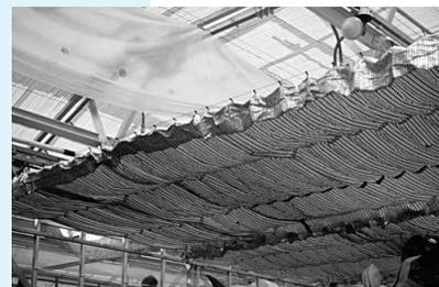
Dans une serre à double paroi de polyéthylène, les pertes par infiltration sont réduites mais, à moins que le film ne soit traité contre les infrarouges, le rayonnement infrarouge s'échappera de la serre.
