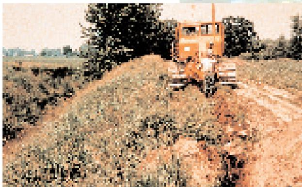
Une fuite d'eau de surface peut causer l'affaissement des berges. Pour éviter l'affaissement, les drains à tuyaux devraient être installés le long d'un talus.
