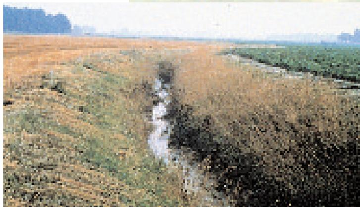
Fossé simple bien aménagé et bien entretenu. Les bandes tampons gazonnées assurent la stabilité des rives du drain et permettent de filtrer le sable qui se déplace dans les eaux de ruissellement.
