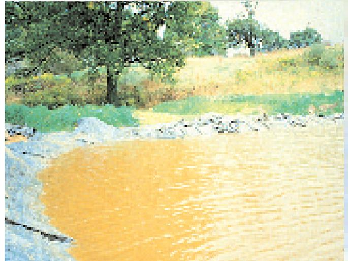
**Procédez à une inspection du sol avant d'entreprendre l'aménagement d'un étang. Il a fallu placer un revêtement en polyéthylène dans cet étang pour retenir l'eau dans le sol en sable.**
