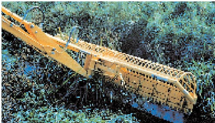
Ces systèmes doivent être entretenus pour être en état de fonctionner. Ici, une benne spécialement conçue enlève l'excès de végétation et de sédiment du bas. Les rives ne sont pas touchées.
