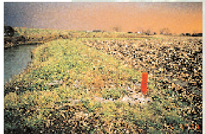
Dans ce système à colonne descendante, une dérivation aménagée le long d'un drain intercepte les eaux de surface et les dirige vers la bouche unique de la colonne descendante.
