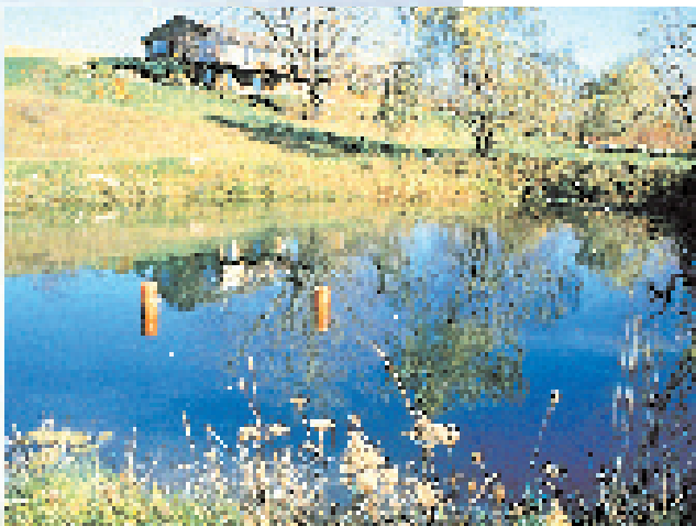
Des conduites d'amenée verticales sont utilisées pour modifier le niveau d'eau dans cet étang à berges aménagé au travers d'une voie de drainage naturelle.
