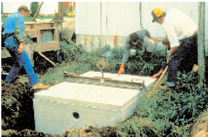
De nombreux producteurs laitiers ont installé un système de traitement et d'élimination visant à prévenir la pollution des ruisseaux par les eaux de lavage de laiterie.
