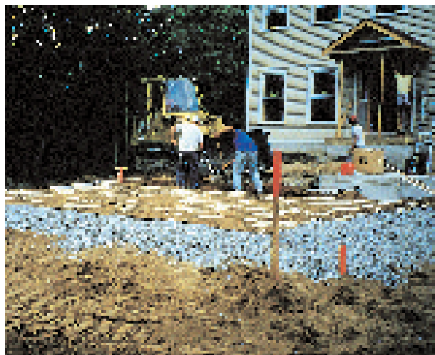
Les plate-formes sont installées sur le substrat rocheux peu profond dans bon nombre de régions de l'Est, du Nord et du Centre de l'Ontario ainsi que dans les secteurs où les sols contiennent de l'argile lourde.
