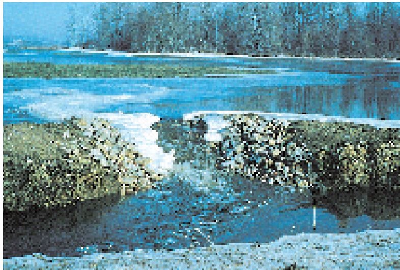
Une descente empierrée bien installée transporte les eaux de ruissellement de la terre labourable vers le canal.
