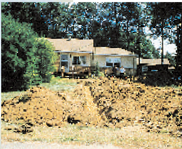
Amélioration des tranchées de traitement d'un champ d'épuration
