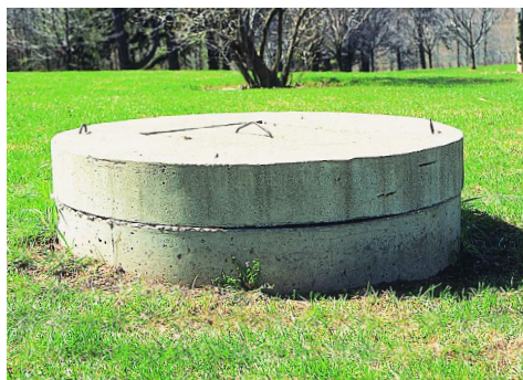
Les puits de grand diamètre ont habituellement un tubage en béton. Le tubage des puits plus anciens peut être en briques, en pierres, en bois ou en tôle d'acier ondulée.
