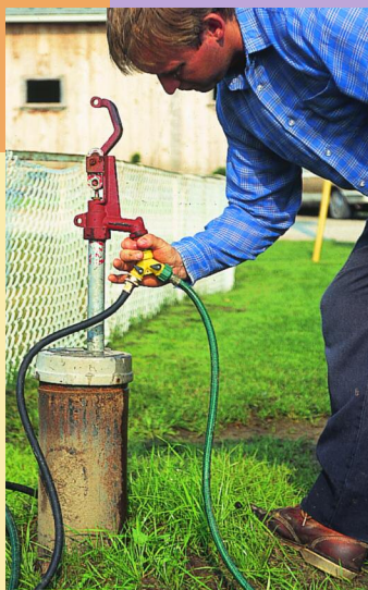
On a ajouté une prise d'eau à l'épreuve du gel avec dispositif anti-retour à ce puits foré à la sondeuse.
