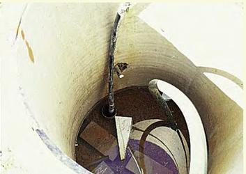
**Un mélange uniforme de bentonite et d'eau a été pompé à l'aide d'un tuyau jusqu'au fond du puits. Le remblayage à partir du fond a assuré un colmatage adéquat, sans risque que le matériel s'agglutine au tubage.**
