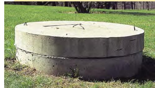
**La hauteur du prolongement du tubage terminé est de 0,4 m (16 po), ce qui répond aux normes de hauteur minimum. Le couvercle de béton est solidement fixé et le gazon environnant assure une meilleure protection, à condition qu'on n'utilise ni engrais ni pesticides la distance recommandée d'au moins 3 mètres (10 pi).**
