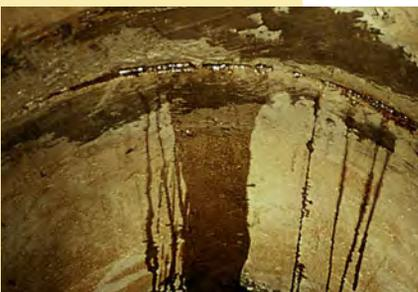
**Essayez de voir et d'écouter si l'eau s'infiltré dans le puits par les joints du tubage ou par des fissures ou des trous.**
