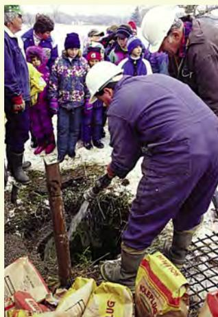
**On a ajouté de l'eau pour activer la bentonite, puis remblayé avec de l'argile propre jusqu'à 3 mètres (10 pi) de la surface.**
