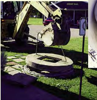
**Le couvercle de béton est enlevé pour ouvrir la fosse. La plomberie et le réservoir sous pression sont enlevés et jetés.**
