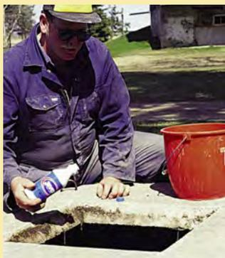
L'eau de Javel doit être utilisée avec prudence dans un puits pour lutter contre les bactéries.
