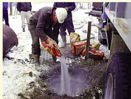
**Un bouchon de bentonite a été formé au niveau de la couche aquifère.**
