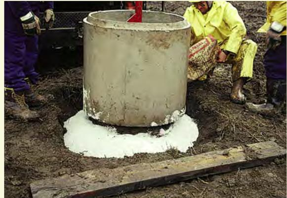
Un large tuyau de béton neuf a été placé au-dessus et autour du tuyau existant. Le joint externe était en bentonite.
