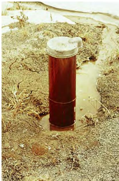
Lorsque ce puits artésien a été construit, il n'a pas été muni d'un mécanisme de régulation. La pression a donc fait déborder l'eau autour du tubage jusqu'à la surface. Il s'agit d'un travail mal fait.
