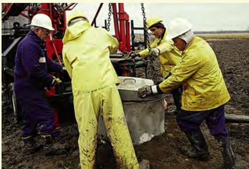
Un couvercle étanche en béton a été mis en place et le sol a été amoncelé autour du puits pour prévenir l'accumulation d'eau de surface. Le coût total des matériaux et de la main-d'oeuvre assurée par un entrepreneur-puisatier autorisé a été d'environ 400 \$. (L'ampleur et le coût de chaque réparation varient; demandez d'abord une estimation.)
