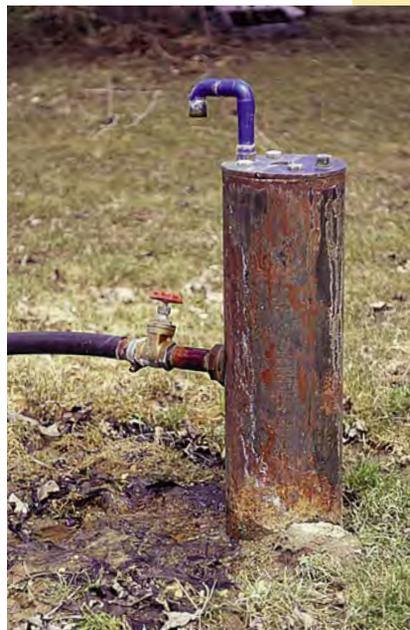
La soupape de surpression sur le tubage offre un certain contrôle sur ce puits jaillissant. Toutefois, une telle construction n'est pas acceptable en elle-même.
