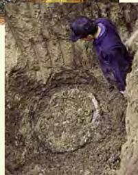
Les tuyaux de béton supérieurs ont été enlevés. Un deuxième bouchon de bentonite a été placé par-dessus les tuyaux restants afin d'éviter que des liquides descendent dans l'ancien puits.
