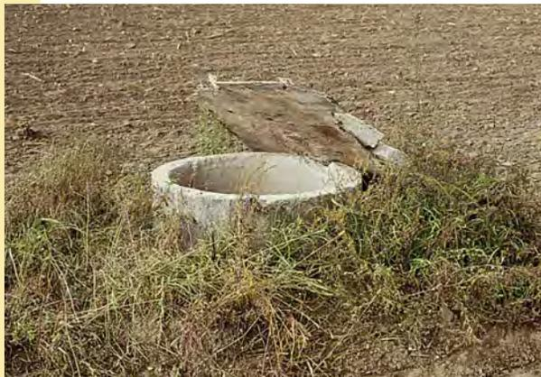
Ce puits devrait être doté d'un couvercle étanche et entouré d'une zone tampon gazonnée pour empêcher les sédiments, le ruissellement de surface et les dérives possibles de pesticides d'y pénétrer.
