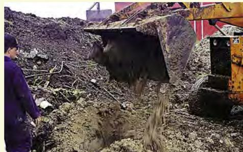
Du remblai d'argile propre a été ajouté jusqu'à 3 mètres (10 pi) de la surface du sol.
