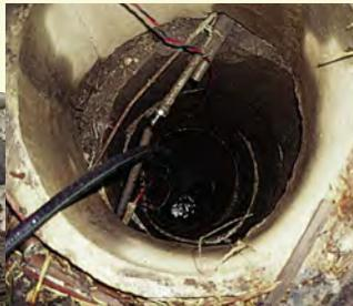
Conditions de départ : l'ancien puits ordinaire a été remplacé par un puits foré à la sondeuse situé tout près; l'ancien puits présentait un danger pour la qualité de l'eau souterraine et pour la sécurité des personnes.
