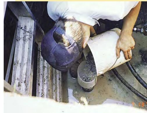
Le remplissage du tubage d'un puits foré à la sondeuse non utilisé de bentonite sèche peut ne pas former un bouchon efficace. Le matériau peut coller ou s'agglutiner dans le tubage, créant ainsi des vides dans le joint.
