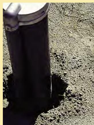
S'il n'est pas scellé, l'espace annulaire autour du tubage de ce puits foré à la sondeuse pourrait laisser entrer de l'eau de surface contaminée directement dans l'aquifère.
