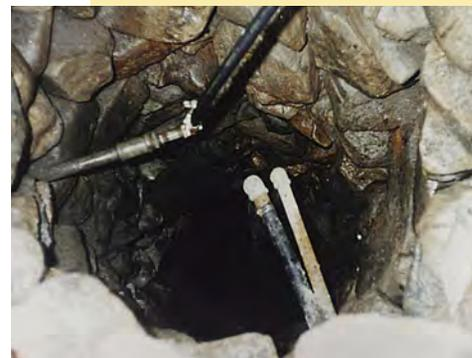
Voici un puits foré à la sondeuse dans un ancien puits ordinaire. L'eau de surface et l'eau souterraine peu profonde peuvent s'accumuler dans l'ancien puits et s'écouler dans le nouveau, causant la contamination.
