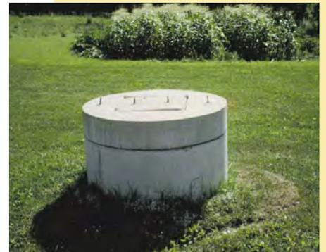
**On considère un puits foré à la tarière comme bien construit lorsque son tubage s'élève à au moins 40 cm (16 po) au-dessus du sol et qu'il est fermé par un couvercle en béton massif, muni d'un évent et à l'épreuve de la vermine.**
