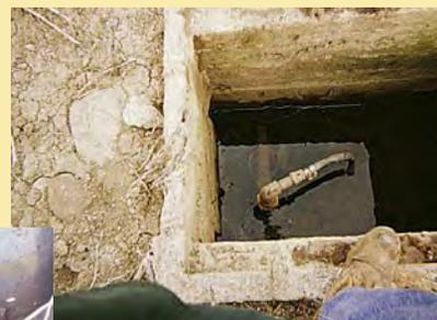
Ce couvercle est submergé dans la fosse. Si le joint est défectueux, le puits peut être contaminé.
