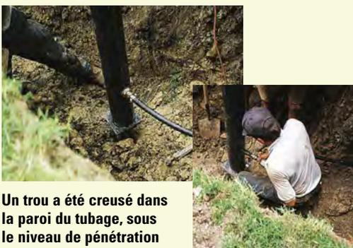
Un trou a été creusé dans la paroi du tubage, sous le niveau de pénétration du gel, pour accueillir l'adaptateur de branchement à coulisseau. On a remis le courant sur la pompe submersible.
