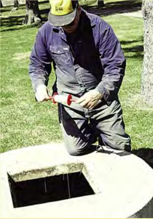
En faisant descendre et monter quelques fois le poids rattaché à la corde et en tendant l'oreille pour entendre le « plouf » du poids quand il plonge dans l'eau, vous pouvez obtenir une mesure du niveau d'eau assez précise.
