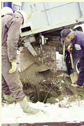
**Des entrepreneurs autorisés ont été engagés pour colmater le puits. On a versé du gravier fin dans le puits afin de former une base solide par-dessus les pierres et les débris qui avaient été jetés dans le puits au fil des ans. Dans certains cas, il faudrait enlever les débris.**
