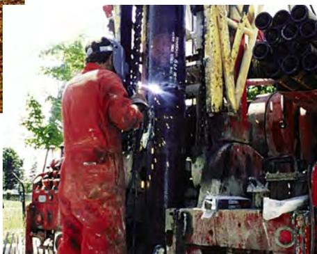
Les joints entre les sections de tubage d'acier sont soudés lorsque ces dernières sont descendues dans le puits.
