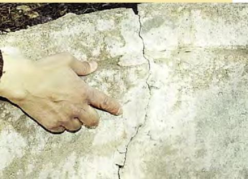
Les fissures visibles dans le tubage doivent être rapidement scellées.
