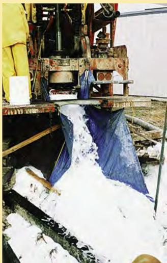
Lorsqu'on redéveloppe un puits, on doit désincruster le filtre ou enlever les joints dans la formation entourant le puits.
