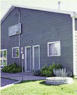
**Condition de départ :** puits non utilisé foré à la sondeuse à une profondeur de 72 mètres (216 pi) dans une couverture de dépôts, situé dans une fosse de puits. L'eau de surface s'accumule dans la fosse et passe à travers le couvercle dans le puits.
