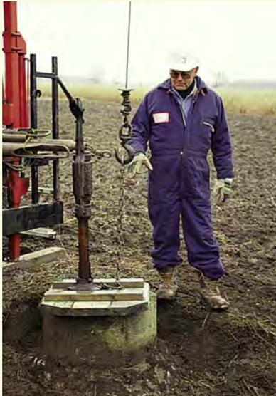
**Condition de départ :** la pompe à bras ne servait plus; l'eau de surface et des débris pénétraient par le couvercle en bois et le tubage en béton fissuré, et des plantes de grande culture poussaient jusqu'à la tête du puits. Ce puits inutilisé constituait un danger pour l'eau souterraine en raison de l'épandage de pesticides et d'engrais sur les terres en culture avoisinantes.
