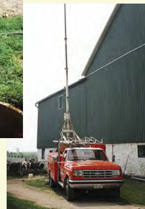
La pompe submersible a été enlevée du puits.
