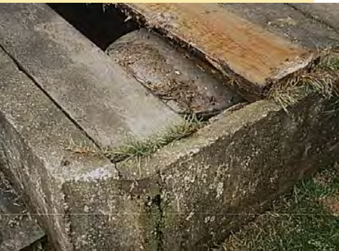
Les planches qui recouvrent les puits n'offrent aucune étanchéité et peuvent pourrir, ce qui les rend dangereuses.
