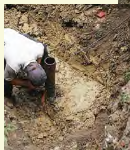
Le tubage en acier a été coupé et une plaque d'adaptation a été soudée afin de soutenir le tubage de prolongement.
