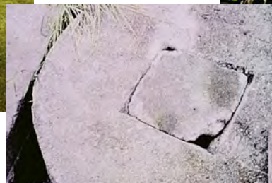
Ces puits mal entretenus n'empêcheront pas l'infiltration de l'eau de surface. Des échantillons d'eau de ces puits révéleraient une numération élevée de coliformes, et peut-être aussi une numération élevée de E. coli .
