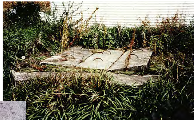
Ces puits mal entretenus n'empêcheront pas l'infiltration de l'eau de surface. Des échantillons d'eau de ces puits révéleraient une numération élevée de coliformes, et peut-être aussi une numération élevée de E. coli .
