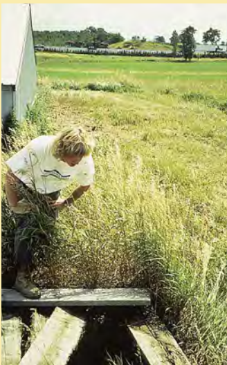
Voici un puits non utilisé en piteux état. Il menacera la qualité de l'eau souterraine et la sécurité des êtres humains, du bétail et de la faune jusqu'à ce qu'il soit colmaté.
