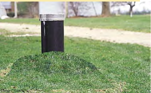
Lorsque vous effectuez la remise à neuf d'un puits existant, assurez-vous que le tubage s'élève à 40 cm (16 po) au-dessus de la surface du sol.
