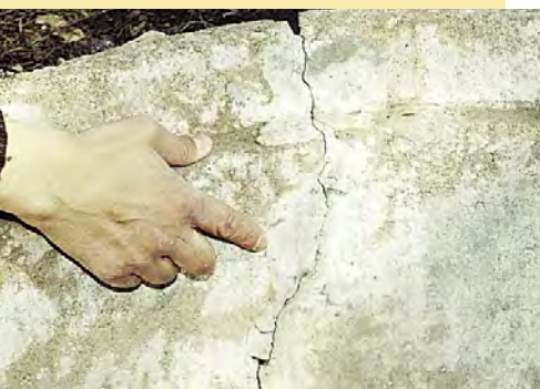
Les fissures visibles dans le tubage doivent être rapidement scellées.
