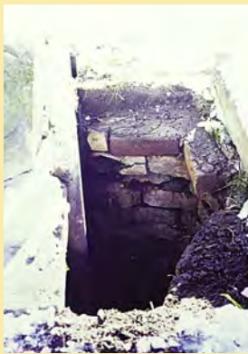
Que cet ancien puits soit muni d'un couvercle ou non, sa paroi en briques peut présenter des problèmes.
