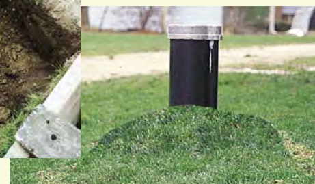
Le trou a été remblayé et un monticule a été formé afin de forcer l'eau de surface à s'éloigner du puits. On a remis le courant électrique et installé un couvercle étanche à évent. Les coûts totaux du matériel et de la main-d'oeuvre assurée par un entrepreneur-puisatier autorisé étaient d'environ 900 $. (Bien entendu, l'ampleur et le coût des travaux varient. Demandez d'abord une estimation.)
