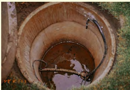
Condition de départ : de l'eau et des débris se sont accumulés au fond de la fosse, risquant de s'infiltrer le long du tubage du puits foré à la sondeuse.
