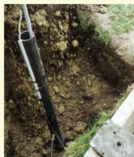
Le trou a été remblayé et un monticule a été formé afin de forcer l'eau de surface à s'éloigner du puits. On a remis le courant électrique et installé un couvercle étanche à évent. Les coûts totaux du matériel et de la main-d'oeuvre assurée par un entrepreneur-puisatier autorisé étaient d'environ 900 $. (Bien entendu, l'ampleur et le coût des travaux varient. Demandez d'abord une estimation.)
