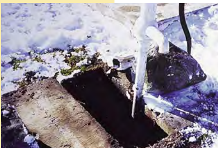
Les puits abandonnés ne doivent jamais servir à entreposer de l'eau de toit, l'eau septique ou tout autre déchet organique.
