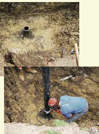
Le tubage en acier a été coupé et une plaque d'adaptation a été soudée afin de soutenir le tubage de prolongement.
