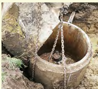
Une pelle rétrocaveuse a enlevé le tuyau qui servait de fosse et a creusé autour du tubage en acier.
