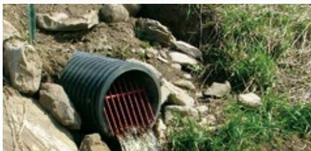
Les sorties du drainage souterrain doivent être dirigées vers l'aval. Elles doivent être protégées par un tuyau rigide avec grille à charnière contre les rongeurs ainsi qu'un bloc parapluie de pierres posées sur du tissu filtrant.
