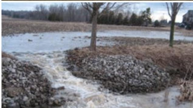
Pour être efficace, un déversoir de taille adéquate recouvert de pierres comprend du tissu filtrant sur lequel sont posées des pierres angulaires de bonne taille.
