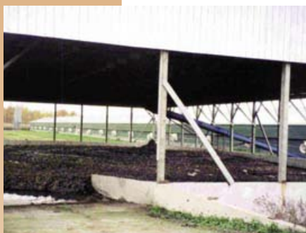
Les structures de stockage couvertes sont préférables.
