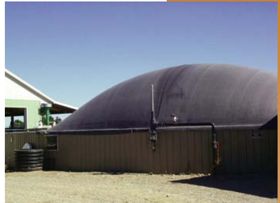
Les biogaz qui sont produits par les digesteurs anaérobies peuvent être brûlés pour produire de la chaleur ou utilisés pour produire de l'électricité.
