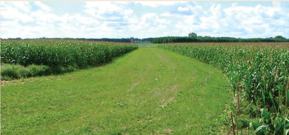
**Les structures de lutte contre l'érosion comme cette voie d'eau gazonnée aident à diminuer le ruissellement et l'érosion en dirigeant l'écoulement dans un canal gazonné vers une sortie sécuritaire. Les structures de lutte contre l'érosion peuvent donc compléter d'autres PGO pour former une série de mesures qui évitent et contrôlent l'érosion du sol et le ruissellement. Au besoin, ces structures représentent un élément essentiel d'un système de conservation du sol.**
