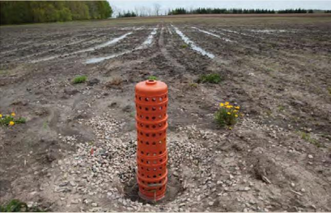
**TUYAU DE CAPTAGE** Les tuyaux de captage (tuyaux verticaux) servent à laisser temporairement s'accumuler les petits débits d'eau en surface.
