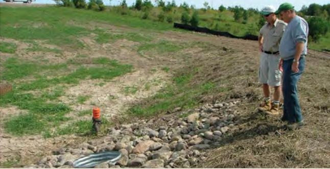
**COLONNE DESCENDANTE** Un tuyau de grand diamètre (colonne descendante) est installé pour acheminer l'eau sur les pentes raides ou les fortes dénivellations, pour éviter que l'accumulation d'eau ou l'écoulement concentré forme de grandes rigoles ou des ravines.
