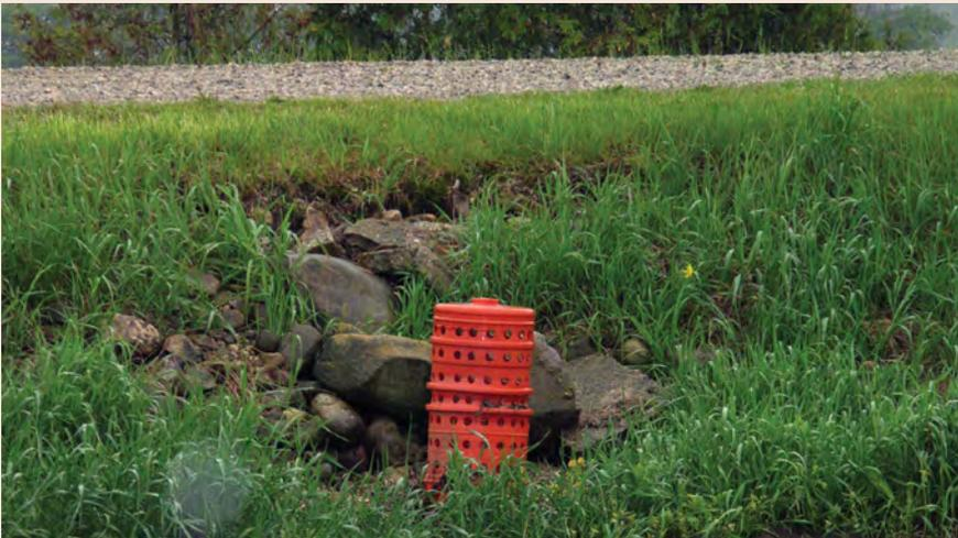
Les bassins de captage et de sédimentation diminuent l'érosion en aval. On calcule soigneusement la durée de l'accumulation temporaire pour diminuer les risques de dommages aux cultures. Inspectez les bassins après les orages importants pour vérifier si des sédiments ou des débris de culture bloquent le tuyau de drainage.
