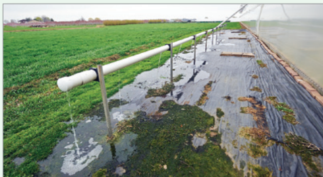
Une bande de végétation filtrante (à gauche) et un bioréacteur à copeaux de bois (à droite) sont des méthodes qui peuvent être utilisées pour traiter les eaux usées.
