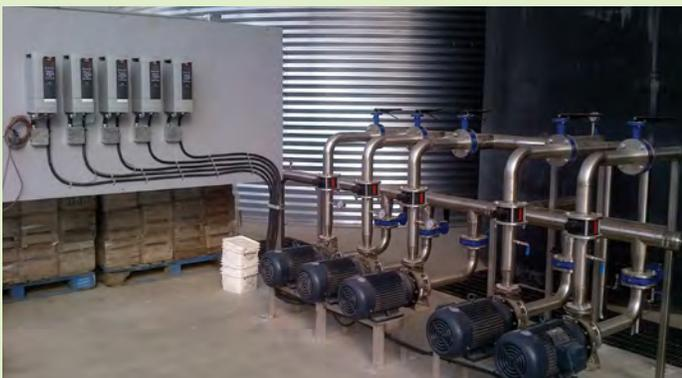
*Le recours à des technologies comme des pompes d'irrigation à démarrage progressif et à vitesse variable améliore la précision du calendrier d'irrigation.*
