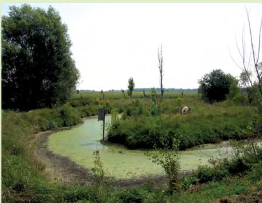
*Les marais artificiels réduisent les concentrations de matières particulaires et d'éléments fertilisants dans les eaux usées produites en post-culture.*
