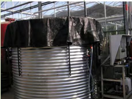
*Les systèmes de filtration lente sur sable sont conçus pour retirer les matières particulaires et les microbes. Les filtres sur sable s'installent et s'utilisent facilement.*
