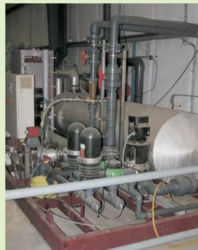
*L'osmose inverse retire les sels (nitrates, sulfates, carbonates), les agents pathogènes et autres micro-organismes de l'eau d'irrigation.*
