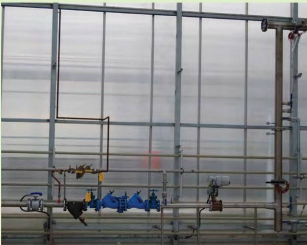
*Les dispositifs anti-retour préviennent la contamination des sources d'approvisionnement en eau fraîche, qu'il s'agisse de l'eau fournie par le réseau municipal ou de l'eau d'un puits. Un limiteur de débit commande le débit maximal dans la serre de manière à solliciter le moins possible le réseau municipal.*
