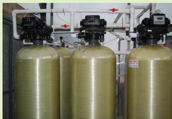
*L'eau de sources relativement propres, comme les puits forés à la sondeuse, a souvent besoin d'une forme de traitement. Une filtration dans la masse et d'autres technologies la débarrasseront des impuretés, comme le fer et le soufre, avant son utilisation.*
