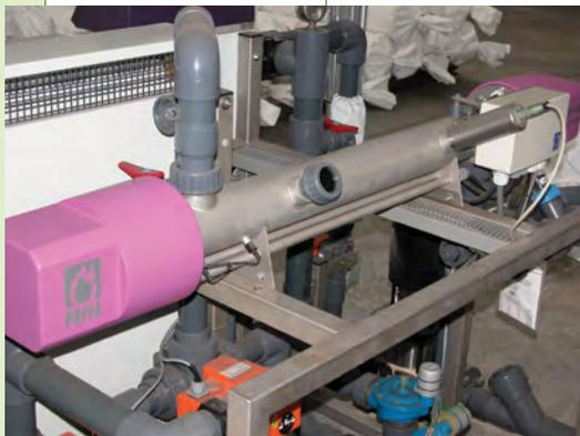
*Utilisez les systèmes de traitement aux rayons UV pour détruire agents pathogènes et autres microorganismes.*
