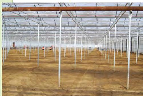
*Modifiez le site pour réduire le risque de contamination des eaux souterraines. Le sol est ici nivelé, compacté et prêt à l'installation d'une bâche de plastique couvre-sol.*
