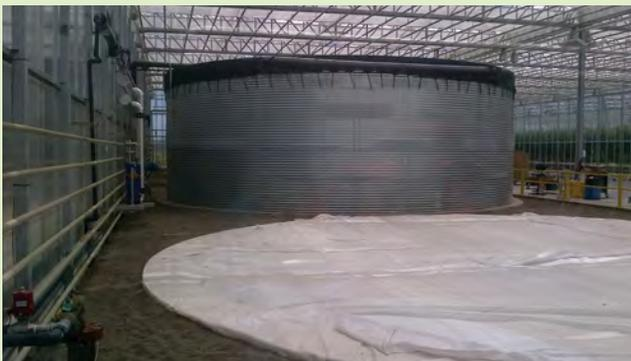
*Stockez l'eau d'irrigation dans des structures à l'épreuve des fuites, comme des réservoirs de stockage revêtus hors-sol.*
