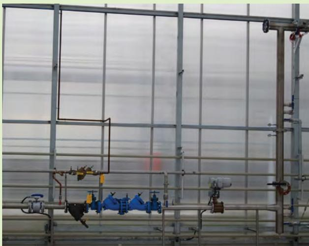
*Les dispositifs anti-retour préviennent la contamination des sources d'approvisionnement en eau fraîche, qu'il s'agisse de l'eau fournie par le réseau municipal ou de l'eau d'un puits. Un limiteur de débit commande le débit maximal dans la serre de manière à solliciter le moins possible le réseau municipal.*
